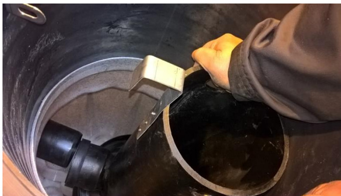
Dra mittenröret från inkommande rör
