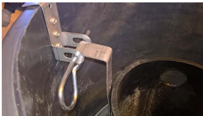
Irrota rasvanerotinputkea paikallaan pitävä R-sokka
