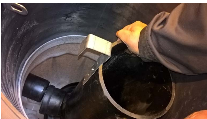
Loitonna erotinputkea tuloputkesta.
